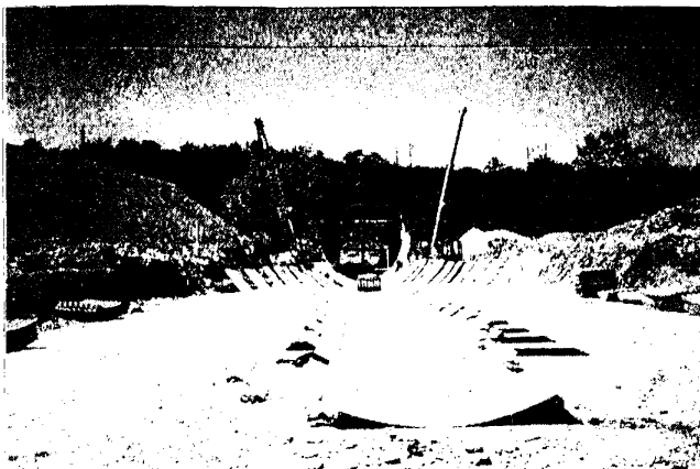
Рис. 20. Сборка МГТ из отдельных элементов
