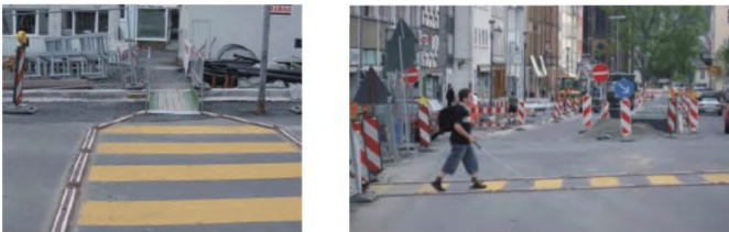
Рисунок 61– Пример обустройства временного пешеходного перехода
