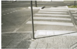
Рисунок 24– Пример выполнения пандусов по краю пешеходного перехода
