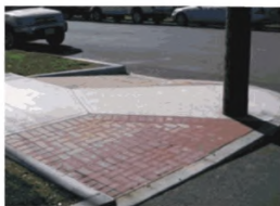
Рисунок 22 – Пример пандусов с бортиками
