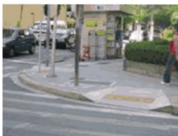
Рисунок 20 – Пример пандуса со скошенными боковыми гранями
