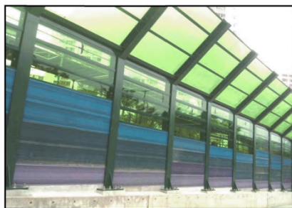
Рисунок 12.8 - Повышение эстетических качеств экранов за счет применения ребристой конструкции и включения прозрачных элементов
