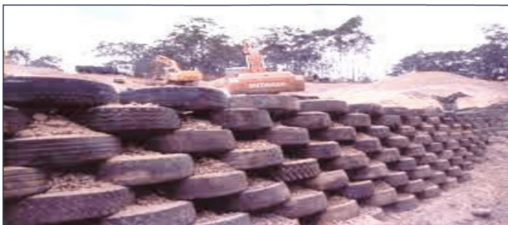
Рисунок 11.52 - Невысокая подпорная стенка шумозащитного вала из утилизированных автомобильных покрышек
