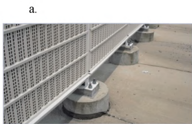
Рисунок 11.41 - Организация отвода воды с устройством паза (а) или отверстия (б) под шумозащитным экраном
