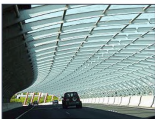
Рисунок 13.2 - Естественное освещение и проветривание шумозащитной галереи
