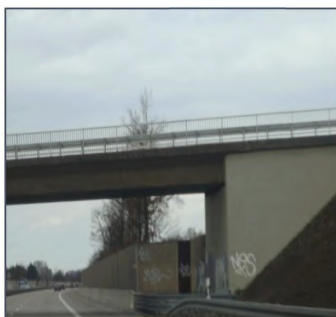
Рисунок 12.13. - Совмещенный с искусственным сооружением начальный участок железобетонного шумозащитного экрана
