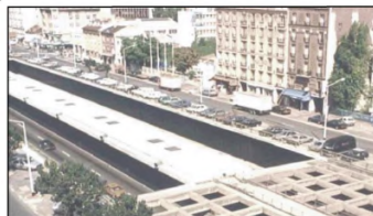
Рисунок 13.2 - Естественное освещение и проветривание шумозащитной галереи
