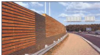
Рисунок 12.14 - Шумозащитные экраны из кирпича разных цветов (а), комбинация шумопоглощающих конструкций из дерева (б) и шумопоглощающих разноцветных панелей (в)
