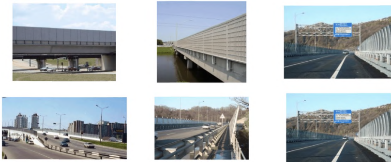
Рисунок 11.44 - Расположение шумозащитного экрана на мостах и путепроводах
