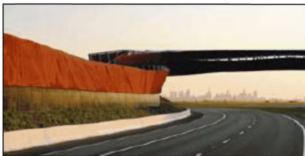
Рисунок 12.6 - Волнообразный верх экран зрительно уменьшает его высоту
