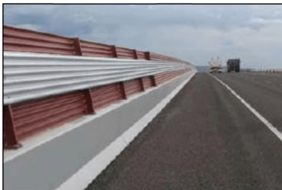
Рисунок 12.5 - Зрительное уменьшение высоты экрана за счет добавлением продольных элементов
