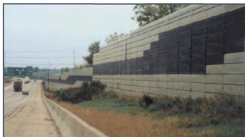
Рисунок 12.14 - Шумозащитные экраны из кирпича разных цветов (а), комбинация шумопоглощающих конструкций из дерева (б) и шумопоглощающих разноцветных панелей (в)
