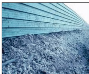
Рисунок 11.38 - Временное размещение снега у шумозащитного экрана в зимний период [12]
