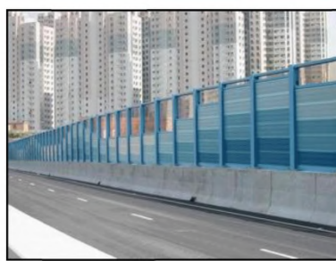
Рисунок 12.8 - Повышение эстетических качеств экранов за счет применения ребристой конструкции и включения прозрачных элементов
