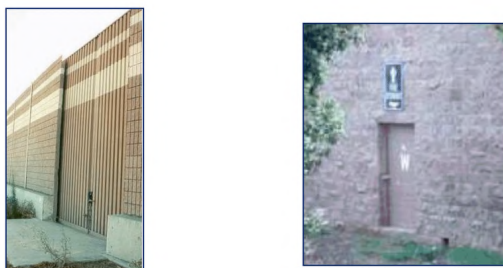
Рисунок 11.34 - Пожарный проход в шумозащитном экране [12]
