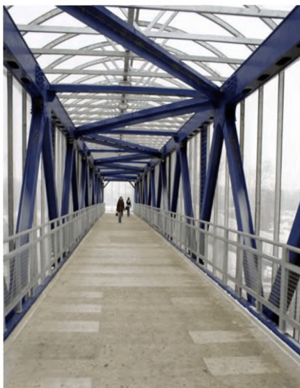
Рисунок К.1 – Рассматриваемый надземный пешеходный переход
