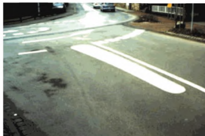
Рисунок 6.9 - Поднятый над уровнем проезжей части (а) и обозначенный краской (б) овалынные островки [13]
