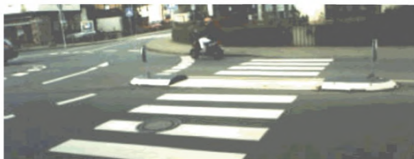
Рисунок 6.10 - Прорезанный приподнятый над уровнем проезжей части разделительный овалынный островок [13]
