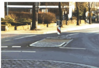
Рисунок 6.9 - Поднятый над уровнем проезжей части (а) и обозначенный краской (б) овалынные островки [13]
