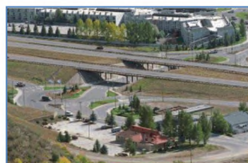
Рисунок В.1 - Кольцевая организация движения в зоне транспортных узлов на примыканиях съездов с магистральных дорог к второстепенному направлению на дорогах Франции и США [7]
