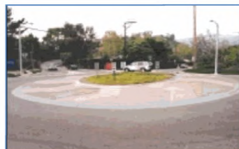
Рисунок 5.5 - Центральный островок с краевой полосой для проезда грузовых автомобилей
