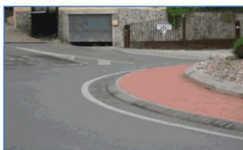
Рисунок 5.5 - Центральный островок с краевой полосой для проезда грузовых автомобилей
