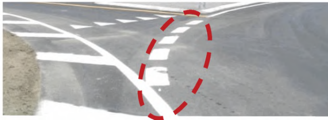
Рисунок 12.4 – Разметка граничной линии кольцевой проезжей части
