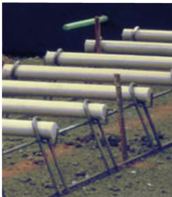
Рисунок А.6 – Расположение металлических анкерных стержней для закрепления закладных элементов шва сжатия
