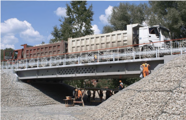
Рисунок В.12 – Испытание моста
