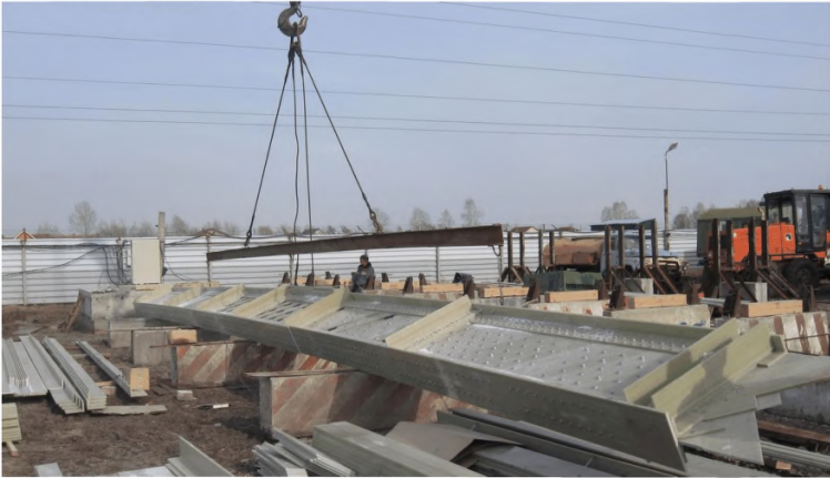
Рисунок В.6 – Подъёмка фермы из горизонтального положения
