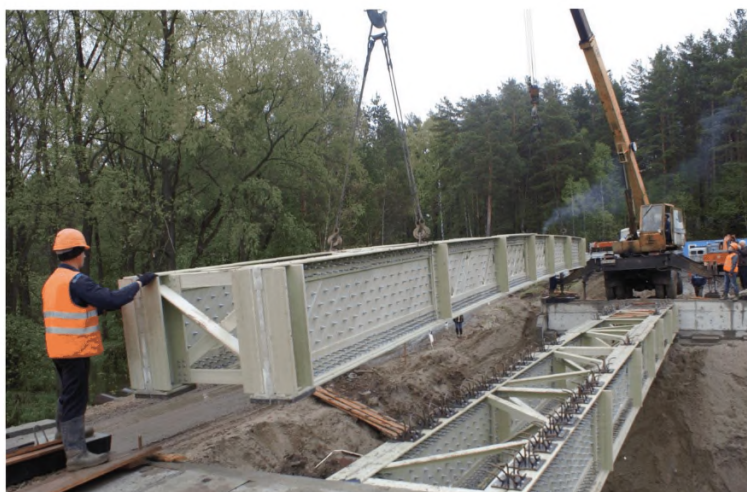
Рисунок В.8 – Установка монтажного блока в пролет
