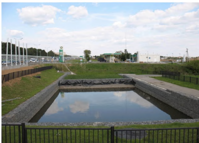
Рисунок 6 – Пруд-отстойник каскадного типа с использованием габионов
