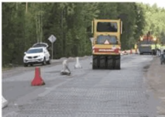
Рисунок 10.5 - Прикатка сетки пневматическим катком
