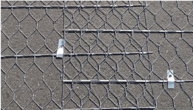
Рис. Е.2 – Предварительное крепление сетки к нижележащему слою.
