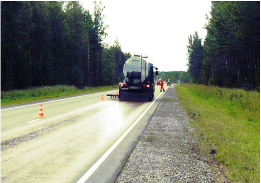
Рисунок 2 – Нанесение пропиточного состава с низкой вязкостью с помощью автогудронатора
