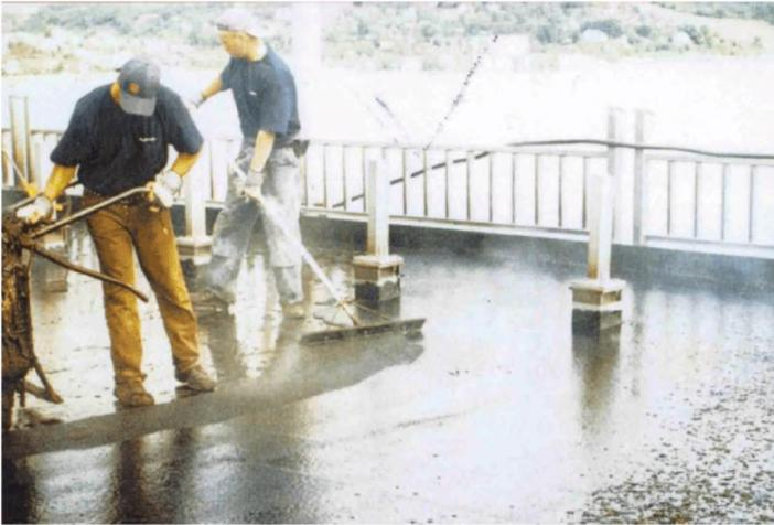
Рисунок В.11 - Укладка гидроизоляционной мастики по полимербитуму
