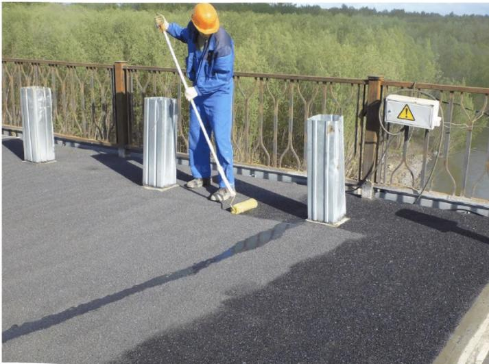
Рисунок В.21 – Нанесение финишного лака «Matacyl STC®»
