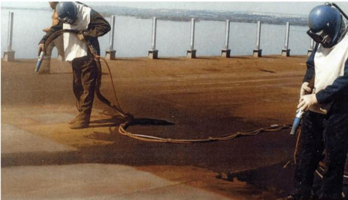
Рисунок В.8 - Пескоструйная очистка поверхности ортотропной плиты
