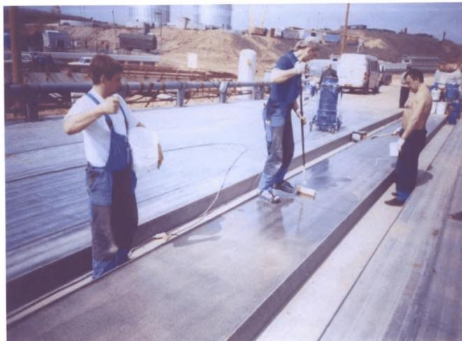
Рисунок В.16 – Нанесение праймера «Matacryn Primer CM<sup>®</sup>», присыпка песком
