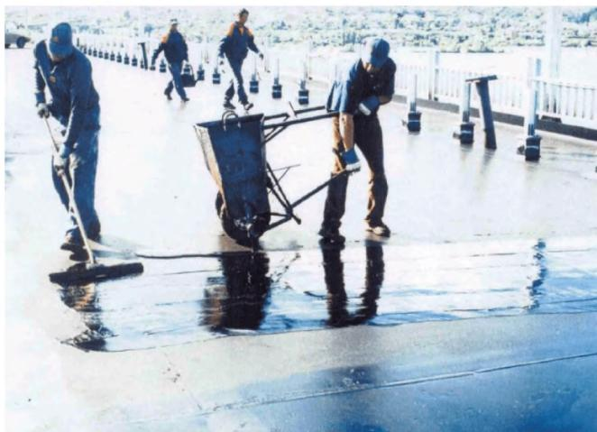
Рисунок В.10 - Разлив полимербитума по разжиженному полимербитуму
