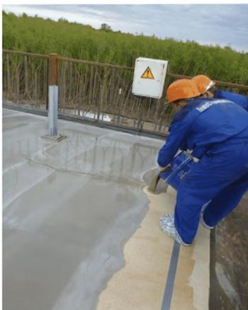
Рисунок В.19 - Нанесение основного износостойкого слоя «Matacryn WL®»
