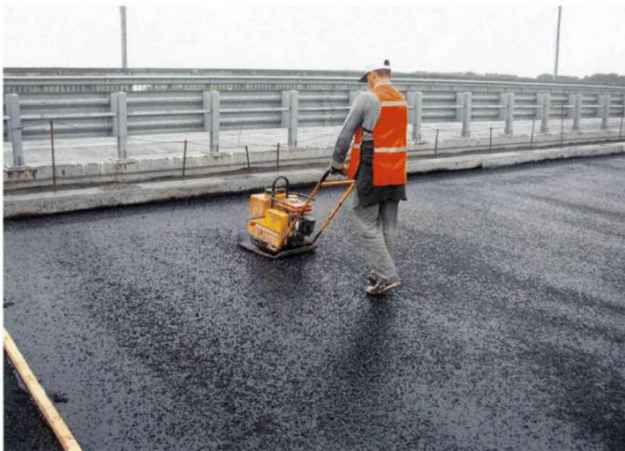
Рисунок В.14 - Втапливание очерненного щебня в литой асфальтобетон в зоне деформационного шва
