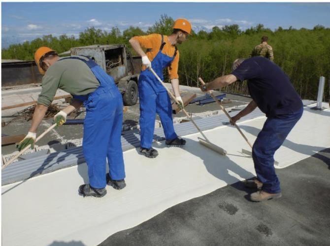
Рисунок В.17 - Нанесение демпфирующего слоя – мастики «Matacyl Manual®»
