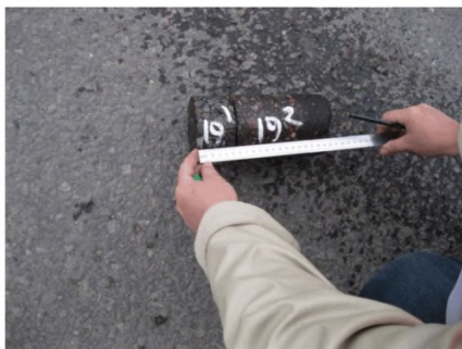
Рисунок 5 – Фотофиксация толщины асфальтобетонных слоев дорожной одежды
