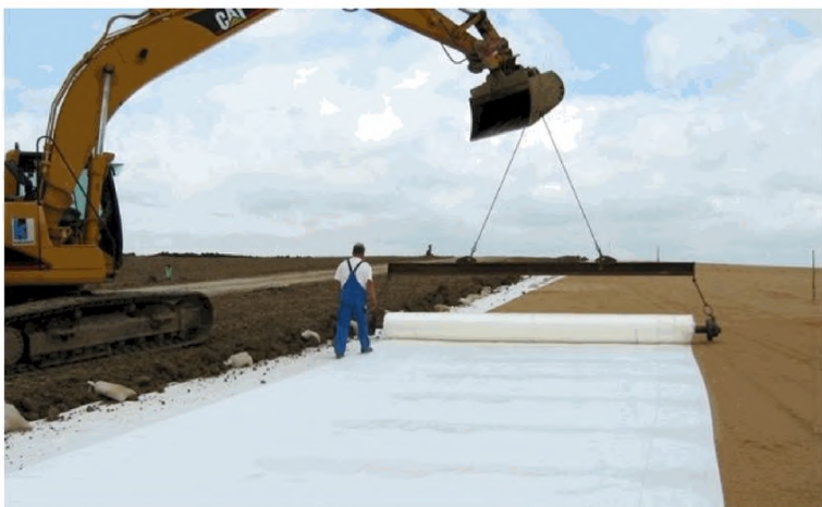
Рисунок 8 - Укладка геотекстиля с применением подвеса на ковше экскаватора
