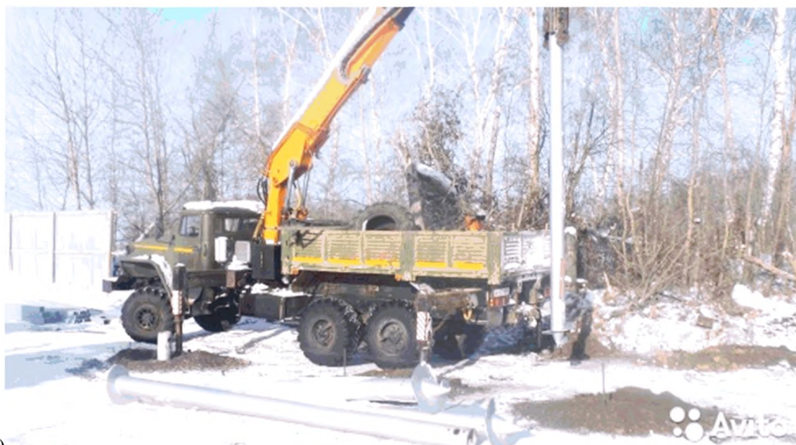
Рисунок Е.2 – Пример монтажа свай СВЛ: а) с использованием электрического завинчивающего устройства; б) с использованием гидравлического завинчивающего устройства: универсальной бурильной машины УБМ-85 на базе грузового автомобиля УРАЛ
