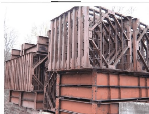
Рисунок 6 – Пример складирования элементов надстройки промежуточных опор моста
