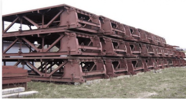
Рисунок 4 – Пример складирования концевых секций моста
