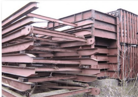
Рисунок 5 – Пример складирования конструкций аванбека моста
