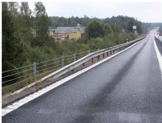
Рисунок 11 – Переходный участок тросового ограждения
