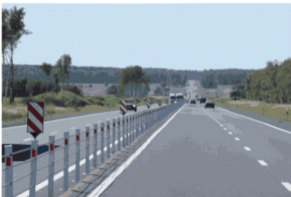
Рисунок 16 - Установка тросового ограждения на оси проезжей части
