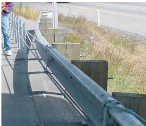
Рисунок 9 – Переходный участок ограждения
