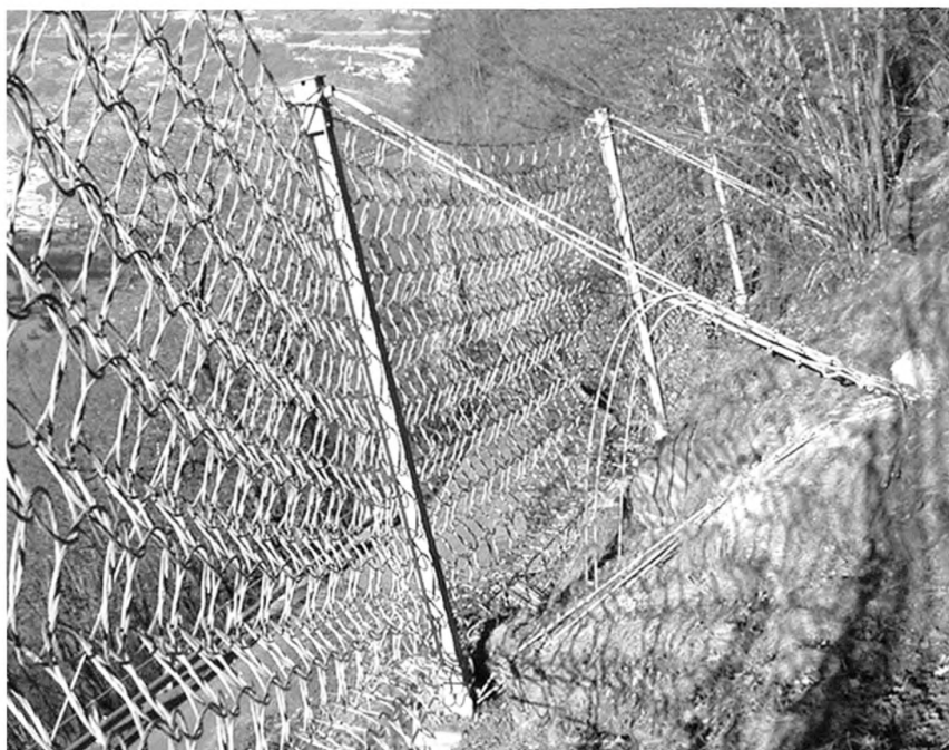
Рисунок А.1 – Пример противокаменной завесы из кольчужной сети (фотография с сайта компании «Гео-Барьер» http://www.geobarrier.ru/projects )
