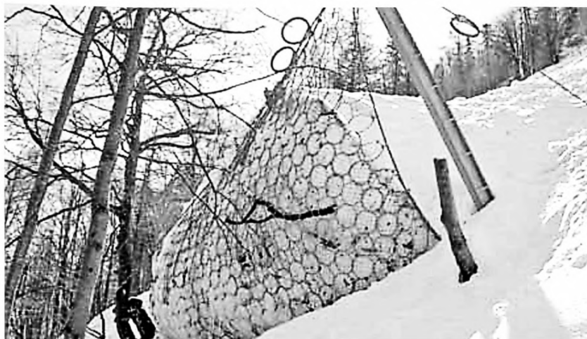
Рисунок А.4 – Пример конструкции снегоудерживающего барьера.
