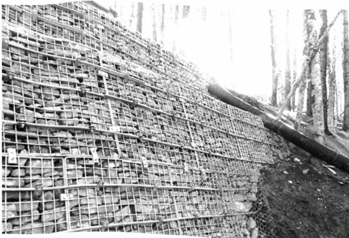
Рисунок А.5 – Пример укрепления лицевой поверхности ГСИ защитными панелями
