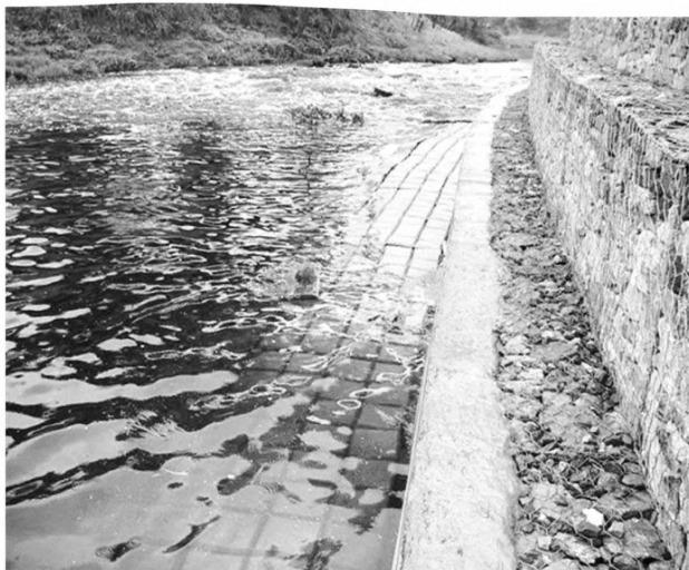
Рисунок А.6 – Пример устройства противоразмывного фартука с применением КГПП
