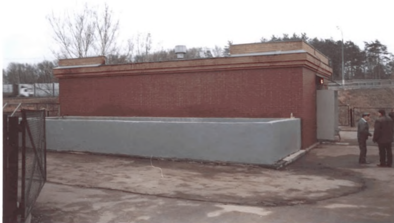
Рисунок 17 - Очистное сооружение индивидуального проектирования (общий вид)
