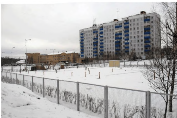
Рисунок 15 - Общий вид очистных сооружений модульного типа
