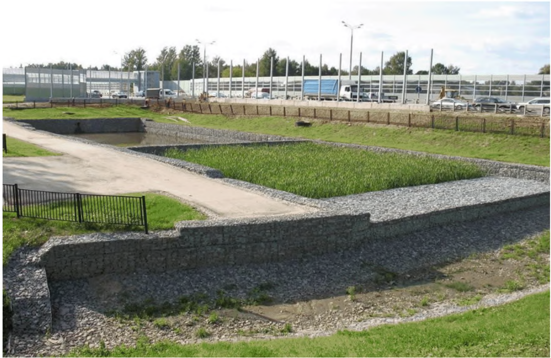
Рисунок 5 - Пруд-отстойник каскадного типа с использованием габионов
