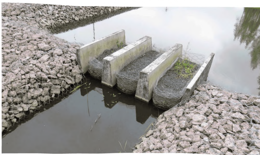
Рисунок 12 – Фильтрующая кассета с загрузкой природным сорбентом
