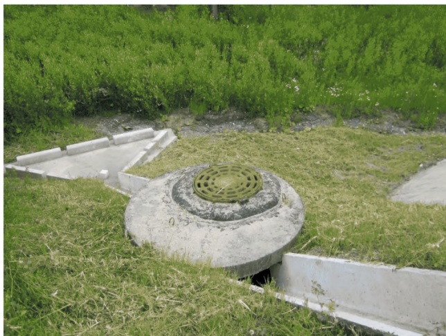
Рисунок 35 – Простейшее очистное сооружение типа «усовершенствованный водоприёмный колодец»
