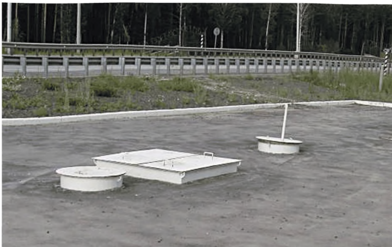
Рисунок 20 – Общий вид станции глубокой очистки подземного расположения
