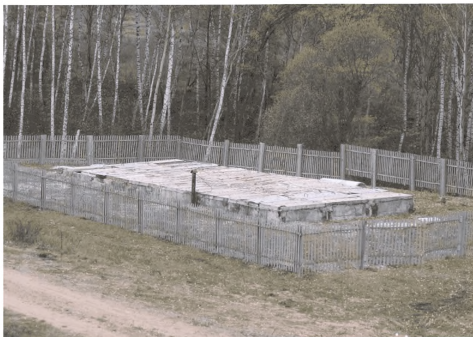
Рисунок 24 - Очистное сооружение индивидуального проектирования кассетного типа (общий вид)
